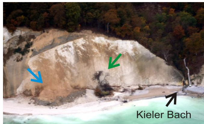
Abb. 7: Aufnahme nach der Rutschung [Foto: Tiepolt]
